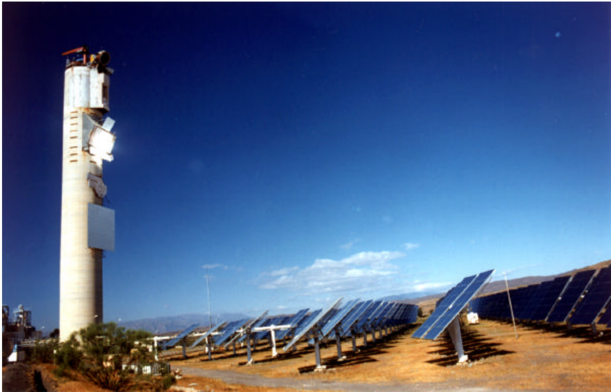
Abb. 4: CESA-1 Solar-Turmkraftwerk auf dem Gelände der südspanischen Forschungseinrichtung Plataforma Solar de Almería (PSA)
