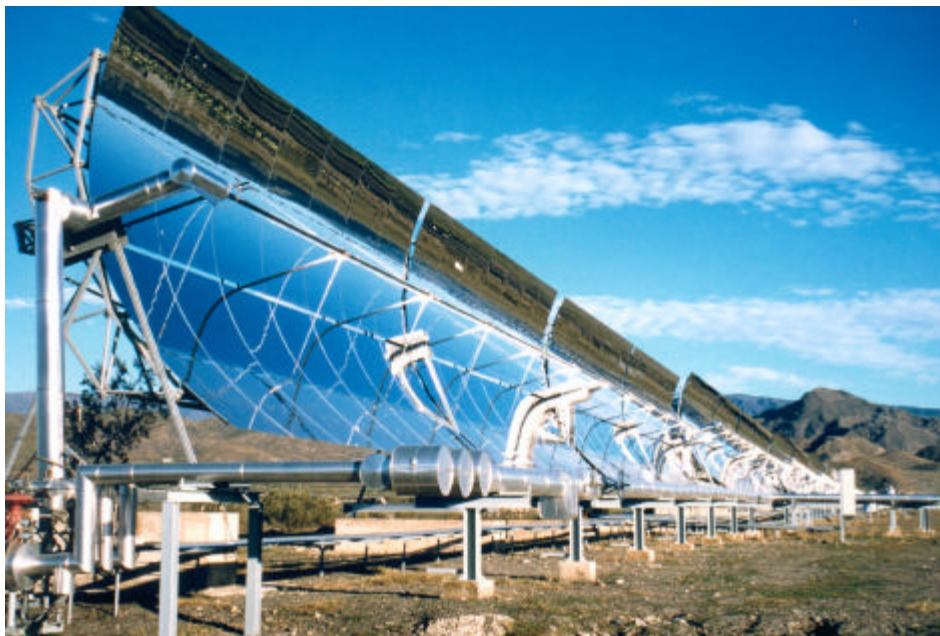
Abb. 3: Parabolrinnen der Direct-Solar-Steam-Versuchsanlage auf der PSA Foto: Volker Quaschnig
